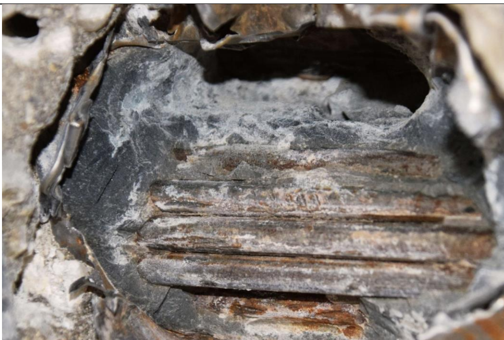
detail drátů předpínací výztuže
