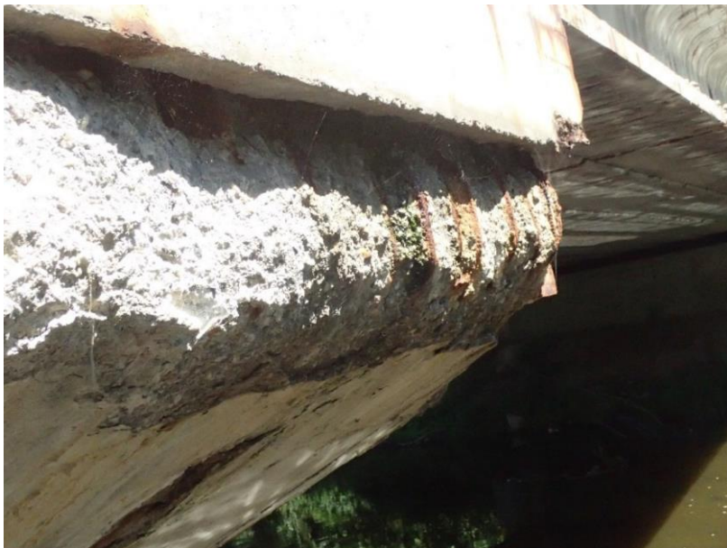
Obrázek č. 3: Koroze výztuže a hloubkové mrazové narušení bočního líce stativa na P1.
