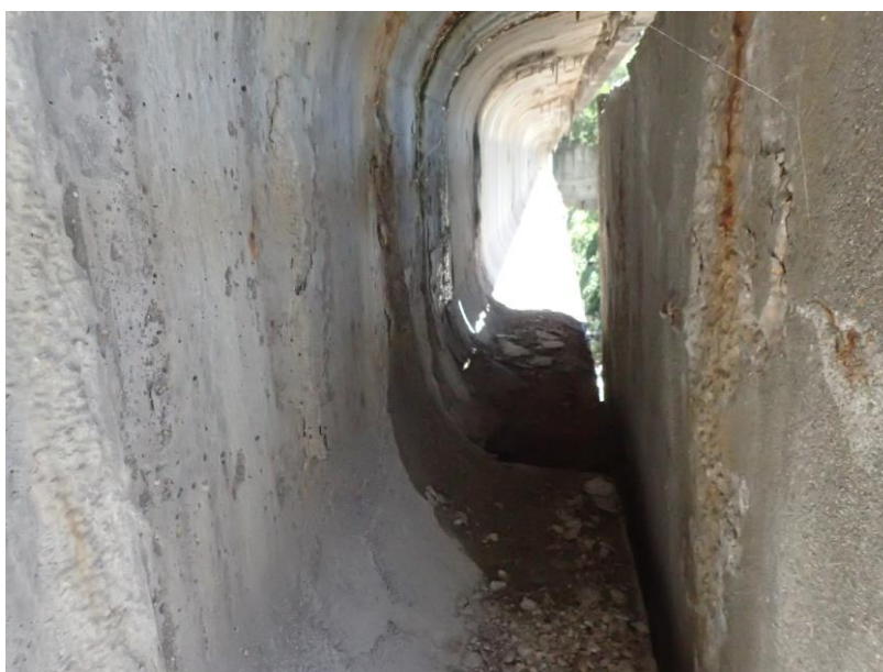
Obrázek č. 6: Záteky na boční líce kraních nosníků
