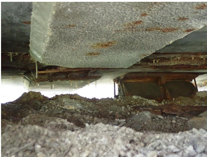
Obrázek č. 1: Zanesení horní plochy stativa opadaným materiálem z NK na P2.
