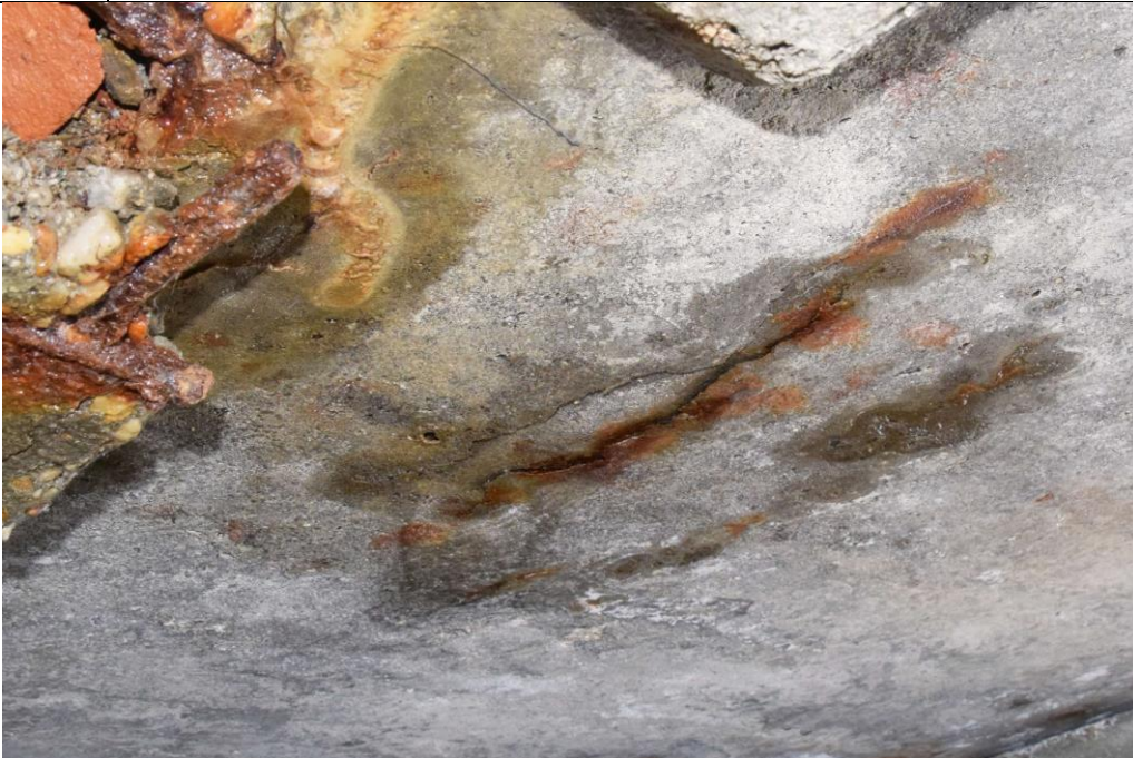
porucha v místě sondy na podhledu
