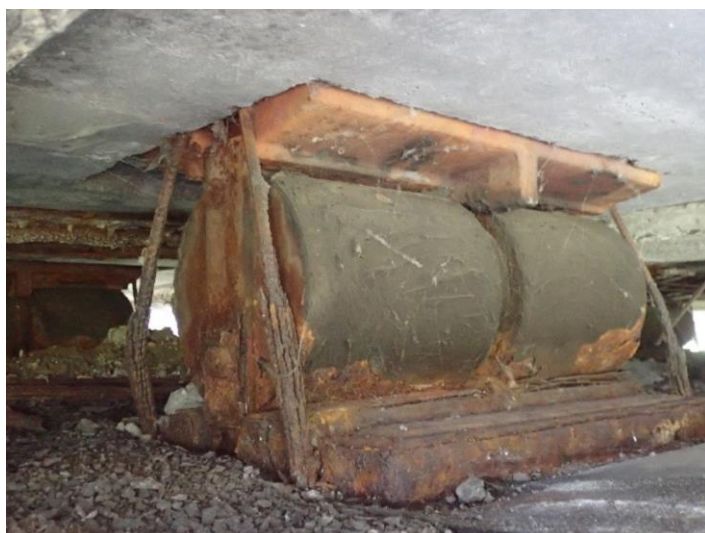
Obrázek č. 4: Dokumentace stavu ložisek na P1
