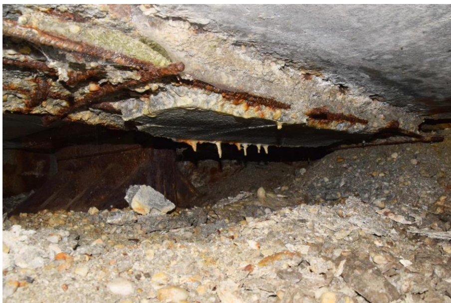
Obrázek č. 9: Rozpad dobetonávky nad P2
