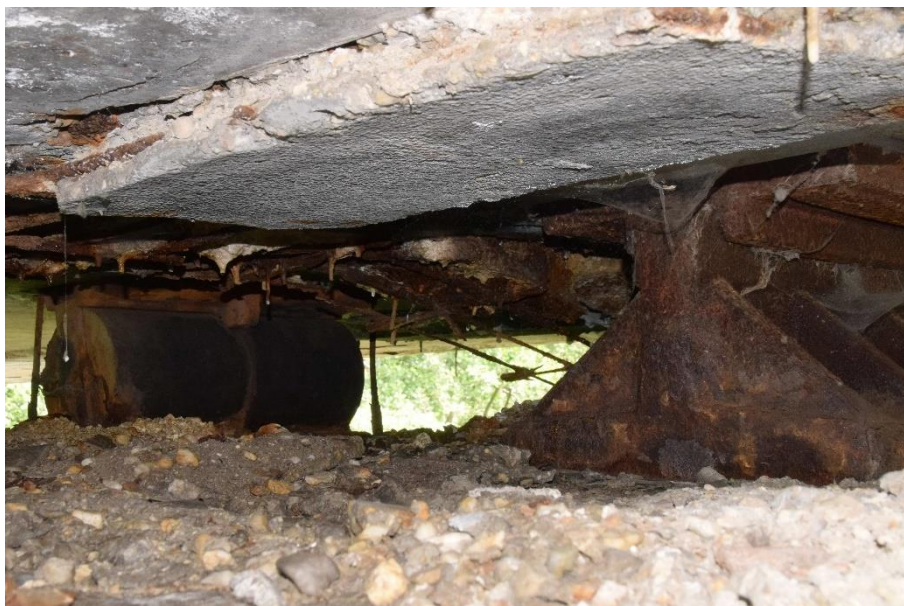
Obrázek č. 5: Dokumentace stavu ložisek na P2
