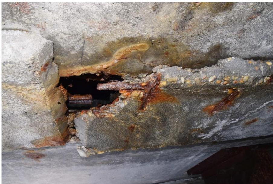
Obrázek č. 8: Rozpad dobetonávky nad P2
