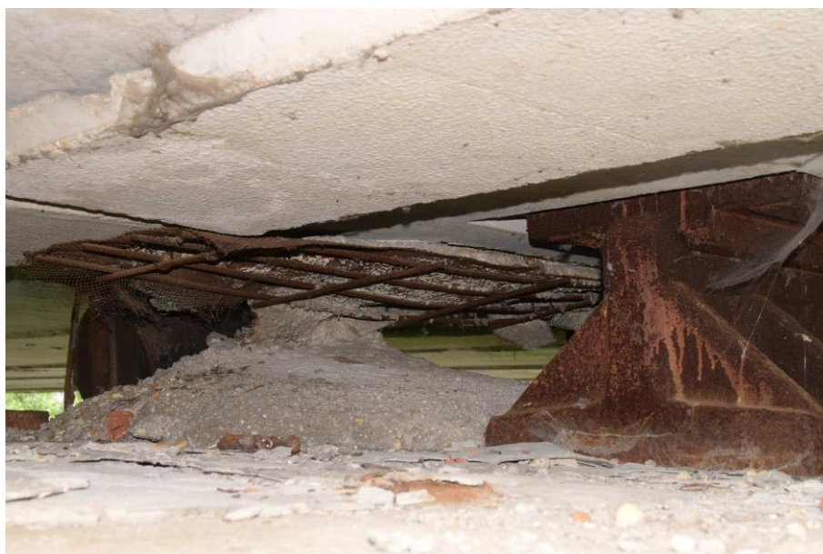
Obrázek č. 8: Způsob „bednění“ dobetonávek konců nosníků
