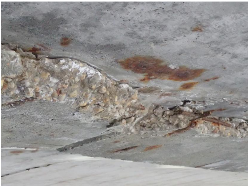
Obrázek č. 9: Rozpad dobetonávky v poli při P1
