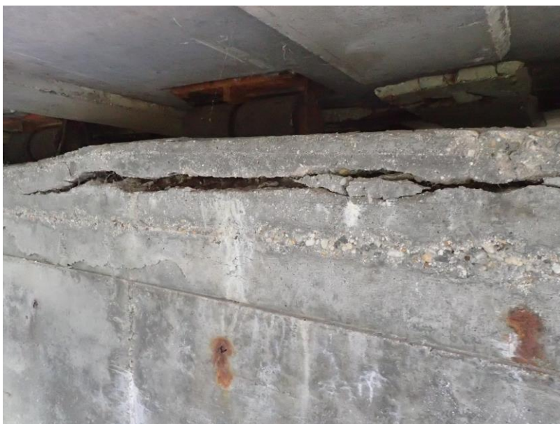
Obrázek č. 2: Utržení horního povrchu stativa z důvodu pokročilé koroze výztuže na P1.
