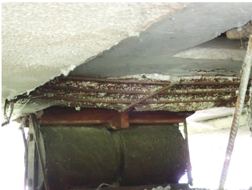
Obrázek č. 7: Koroze měkké výztuže na podhledu krajního nosníku (na nátoku)
