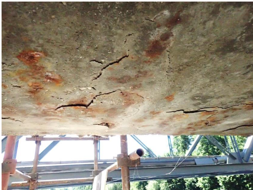
Obrázek č. 7: Koroze měkké výztuže na podhledu krajního nosníku (na nátoku)
